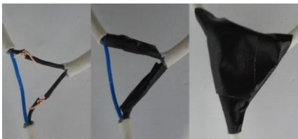
Gambar 4. Penambahan, Penyambungan Kabel Pada Saklar
